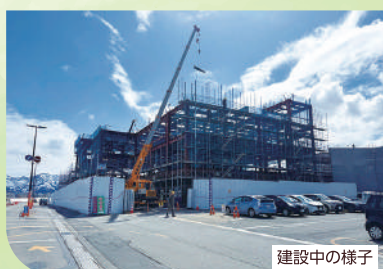
建設中の様子
